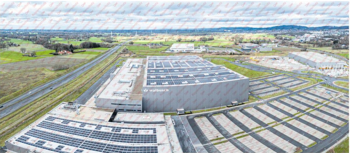
Vergangenen Dienstag (20. Februar) ist die Photovoltaik-Anlage von Walbusch nach einem Jahr Bauzeit ans Netz angeschlossen worden. Sie produziert mehr Strom, als von Logistikzentrum und Outlet-Center benötigt werden. Foto: Ulrich Falke
