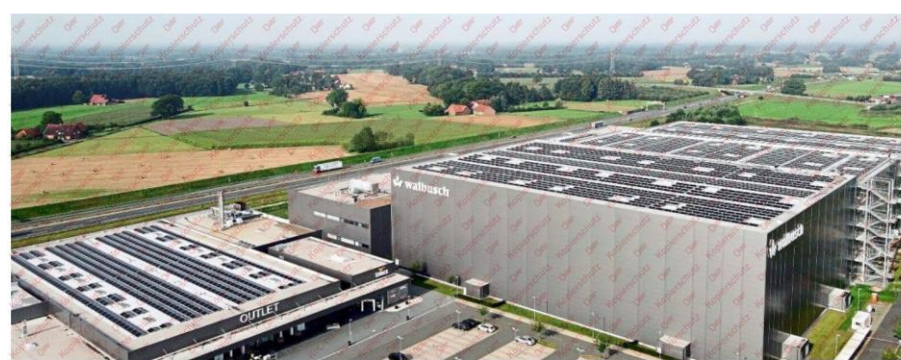
Diese von Walbusch zur Verfügung gestellte Luftaufnahme zeigt die Größe der Photovoltaik-Anlagen auf dem Dach des Outlets und des Logistikzentrums im Ravenna-Park. Foto: Walbusch
