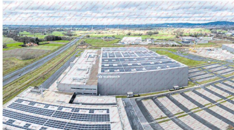
Vergangenen Dienstag (20. Februar) ist die Photovoltaik-Anlage von Walbusch nach einem Jahr Bauzeit ans Netz angeschlossen worden. Sie produziert mehr Strom, als von Logistikzentrum und Outlet-Center benötigt werden. Foto: Ulrich Falker
